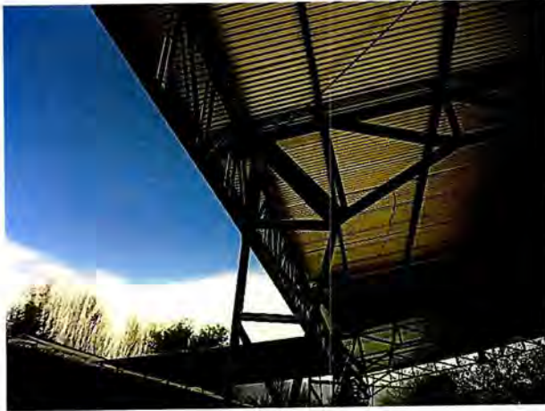
Fotografía N° 36: Detalle de instalación eléctrica en recinto.
