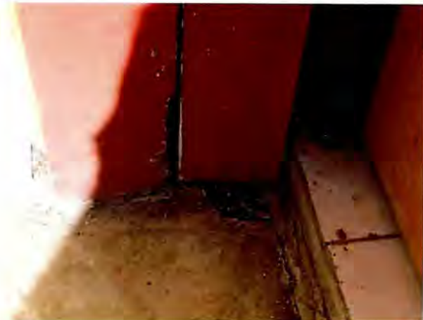
Fotografía N° 11: Vista de la unión de muros en su parte inferior.
