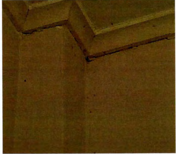
Fotografía N° 23: Detalle de encuentro de muro y cielo.
