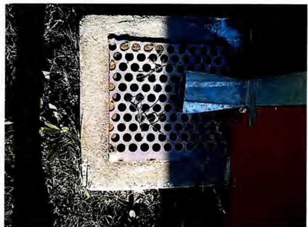
Fotografía N° 19: Detalle de baja de aguas lluvias.
