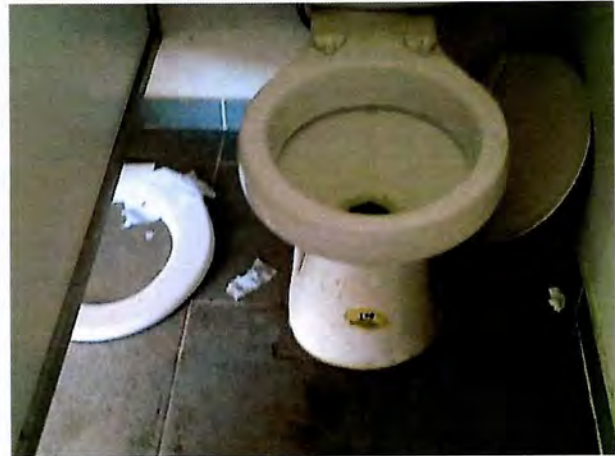
Fotografía N° 27: Vista de los servicios higiénicos, sector wc.
