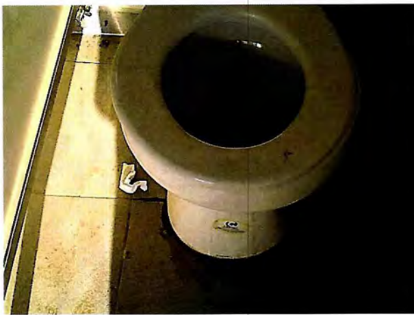
Fotografía N°28: Detalle de los sectores intervenidos.
