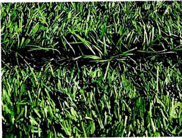
Fotografía N°53: Vista del desprendimiento de la palmeta de pasto sintético.
