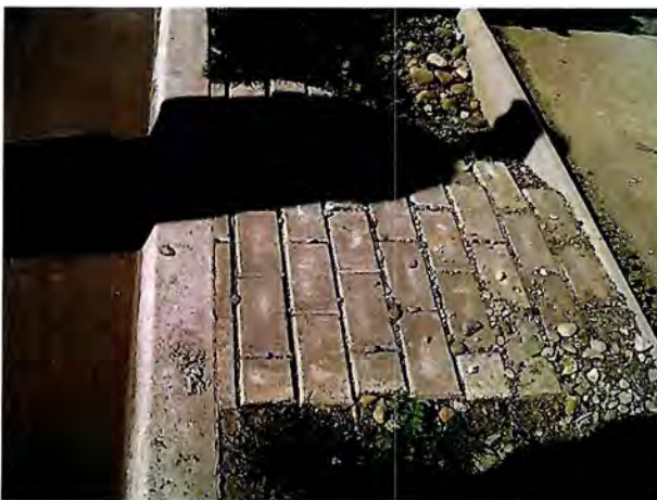
Fotografía N° 39: Detalle de pavimento de adoquines ejecutado.
