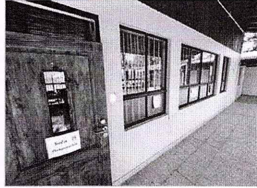
Rejas de protección en ventanas
