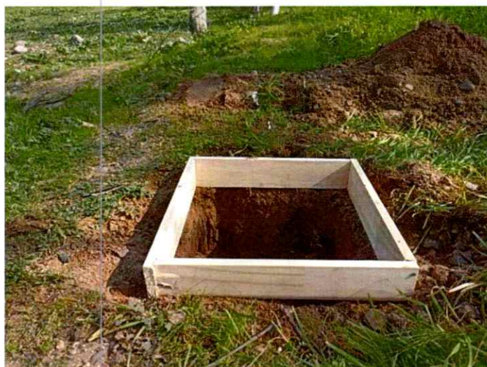
Fotografía 1. Ejemplo de Construcción de Monolitos RRP
