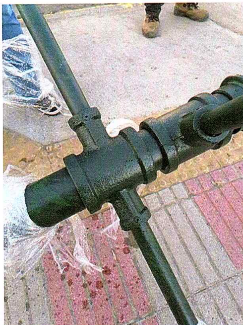
Ilustración 14 "Abrazadera para instalar señalética doble 1"
