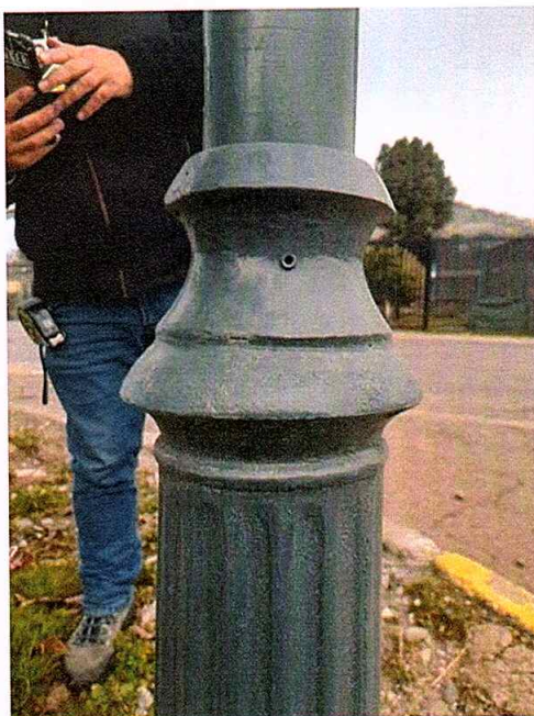
Ilustración 13 "Base Olimpo instalada 2"
