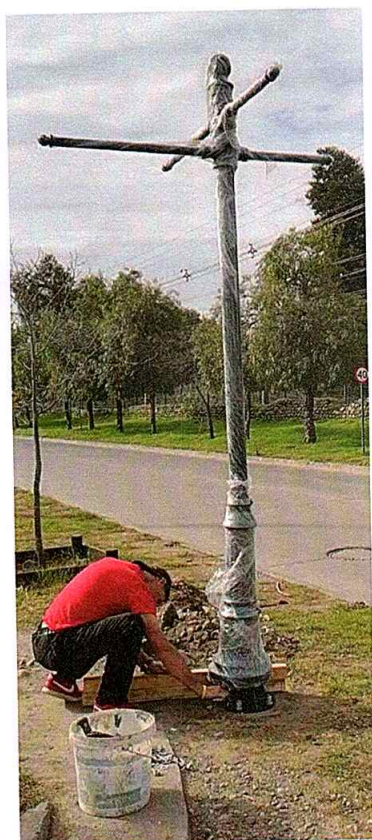
Ilustración 8 "Fijación de poste"
