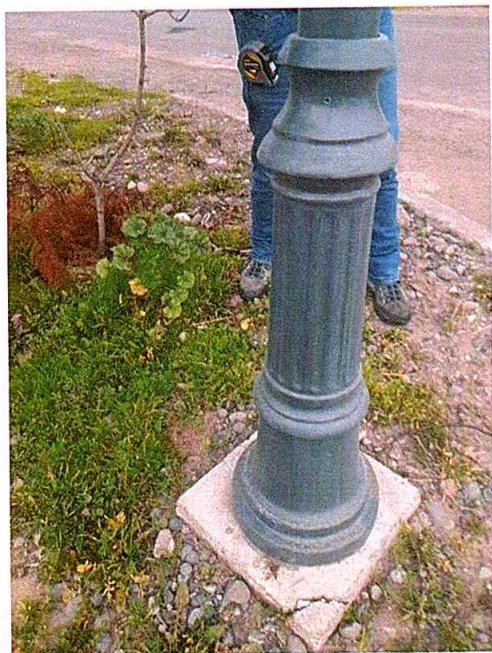
Ilustración 12 "Base Olimpo instalada 1"
