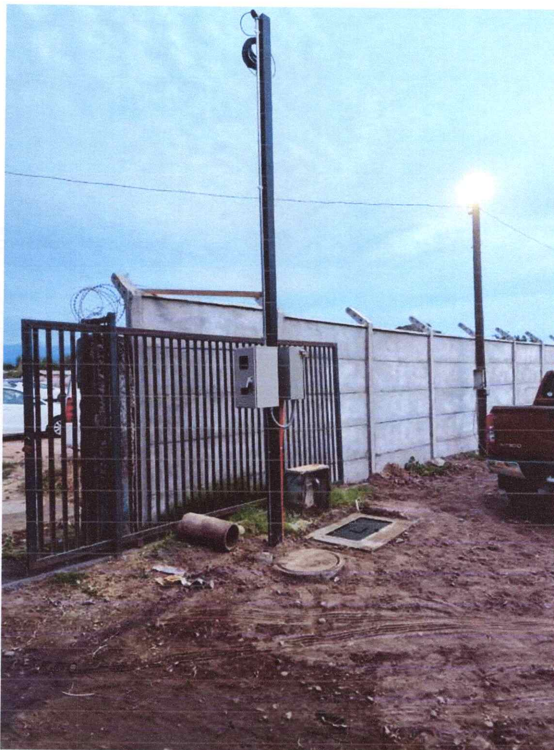
IMAGEN 21: ITEM 4.2 INSTALACION DE AGUA POTABLE.
