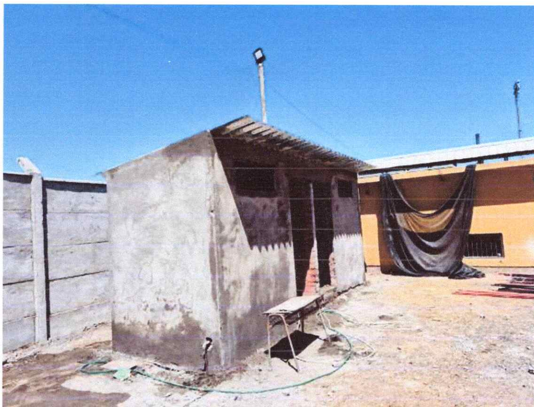
IMAGEN 7: ITEM 2.2 RADIER Y ZOCALO DE HORMIGON.
