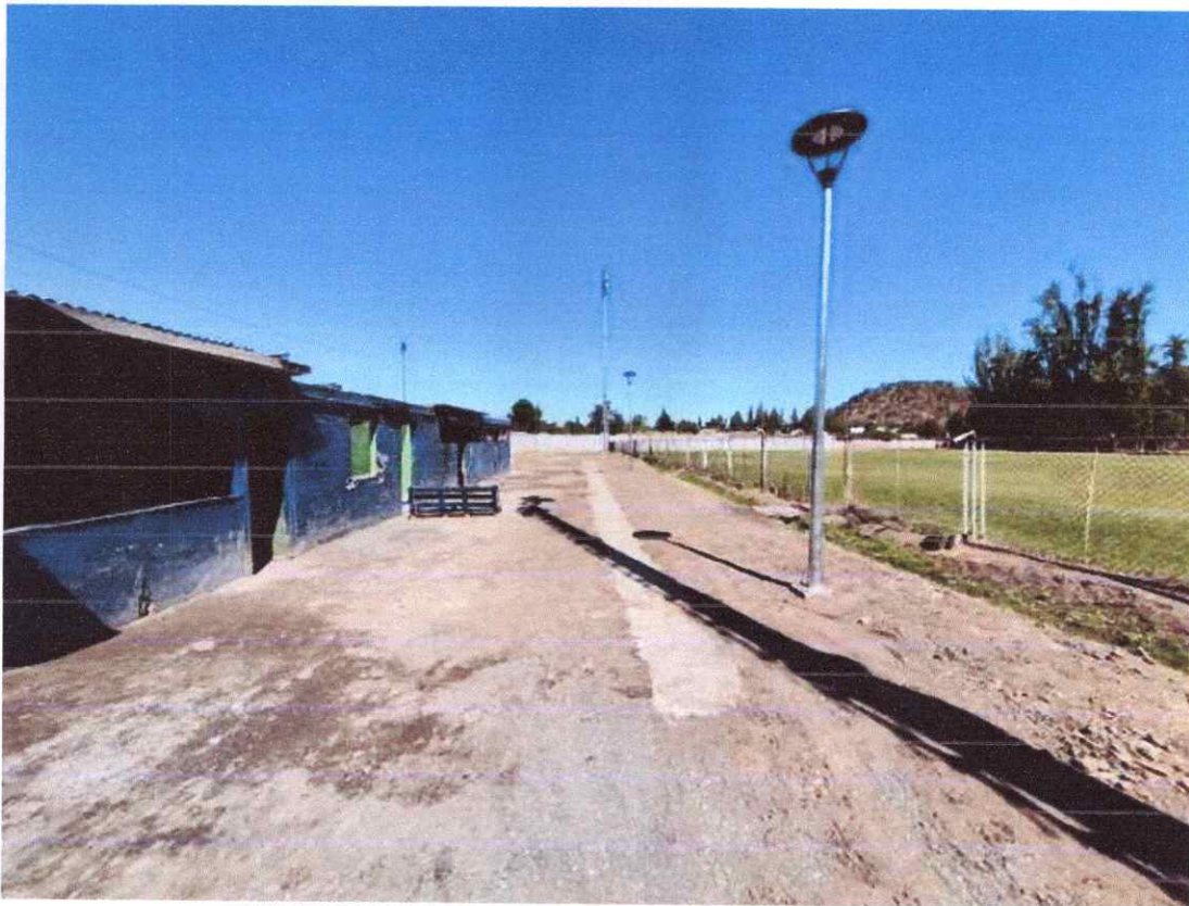
IMAGEN 33:ITEM 4.3 INSTALACION ELECTRICA.
