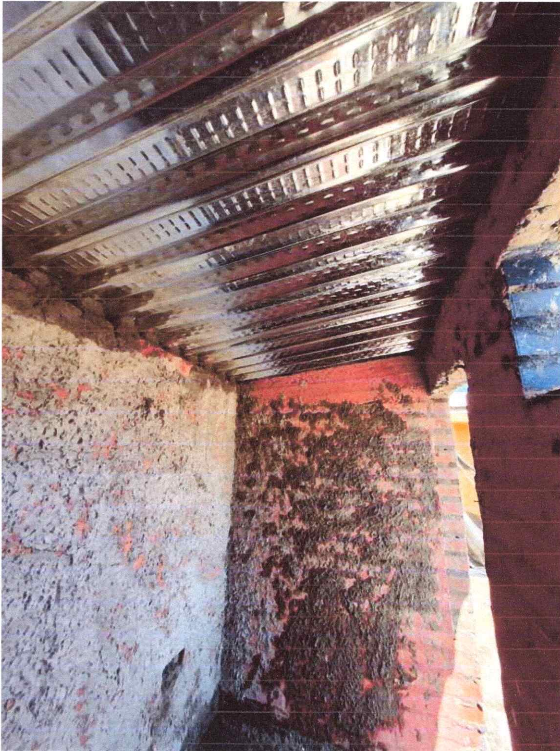
IMAGEN 6: ITEM 2.1 LOSA COLABORANTE CUBIERTA.
