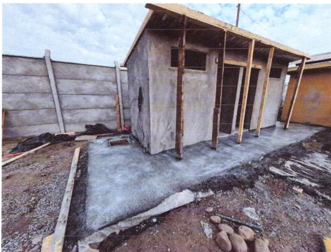
IMAGEN 8: ITEM 2.2 RADIER Y ZOCALO DE HORMIGON.
