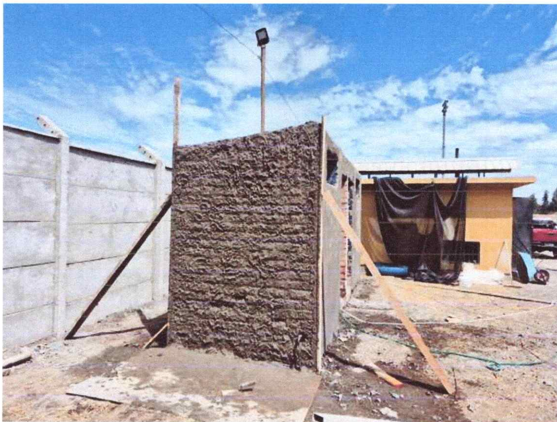
IMAGEN 10: ITEM 3.1 ESTUCO EXTERIOR E INTERIOR.
