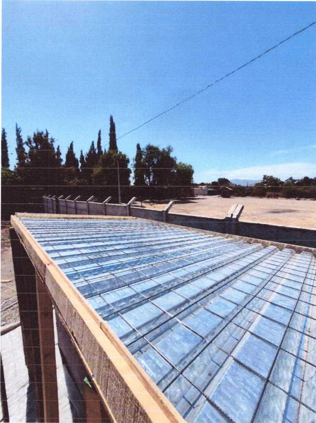
IMAGEN 5: ITEM 2.1 LOSA COLABORANTE CUBIERTA.
