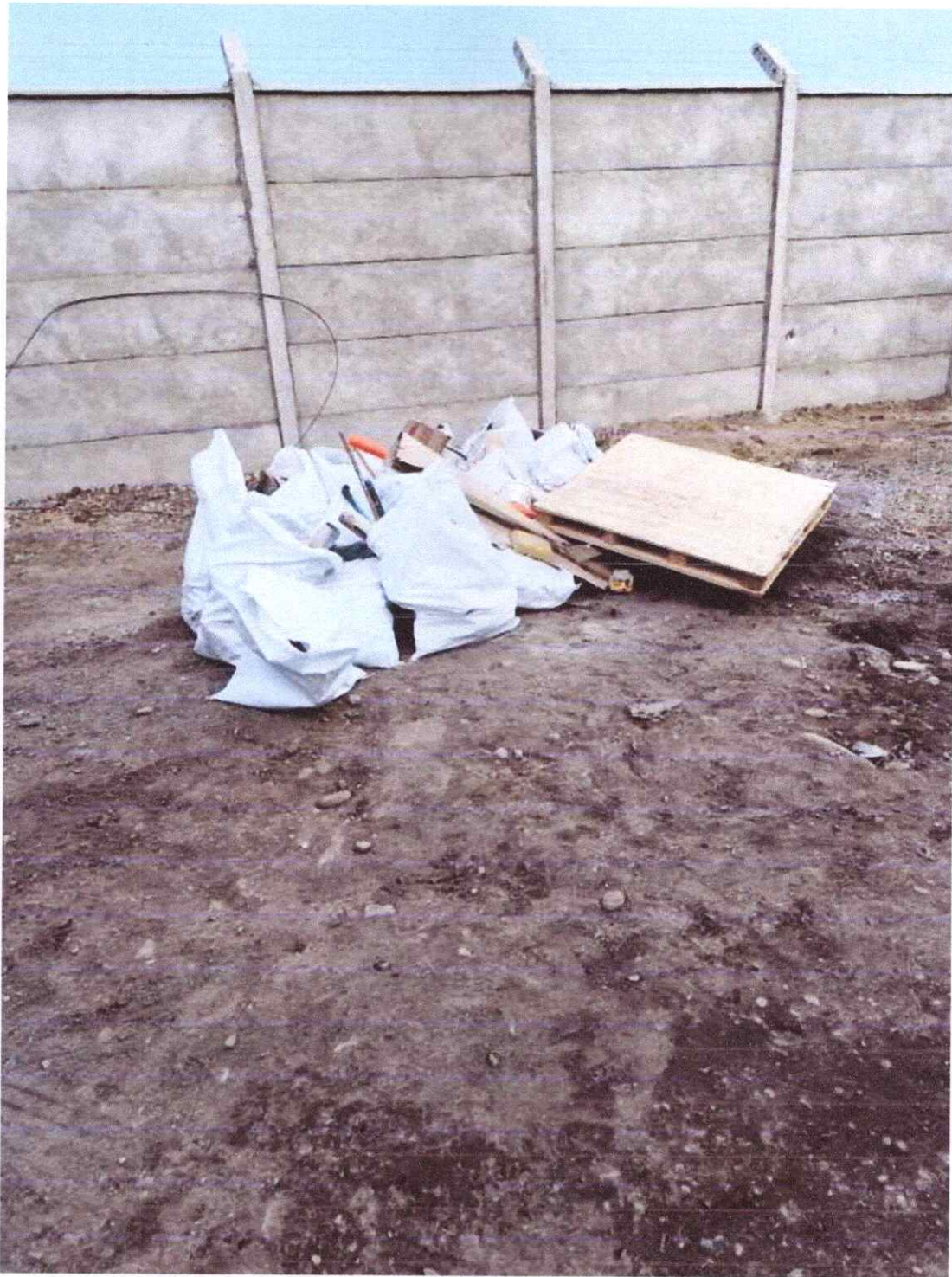
IMAGEN 34: ITEM 5 ASEO GENERAL, LIMPIEZA Y ENTREGA FINAL.
