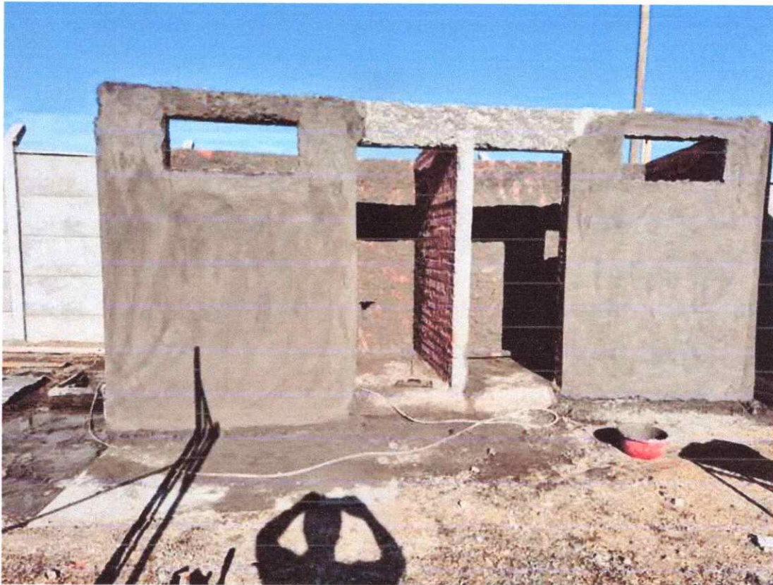
IMAGEN 11:ITEM 3.1 ESTUCO EXTERIOR E INTERIOR.
