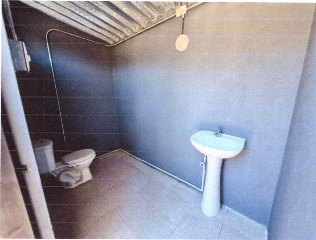
IMAGEN 32:ITEM 4.3 INSTALACION ELECTRICA.
