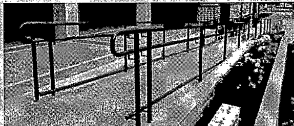
Foto 51: Rampa con pasamanos a doble altura. Ambos pasamanos deben ser continuos, de manera que el deslizamiento de la mano no se interrumpa en todo el trayecto.
