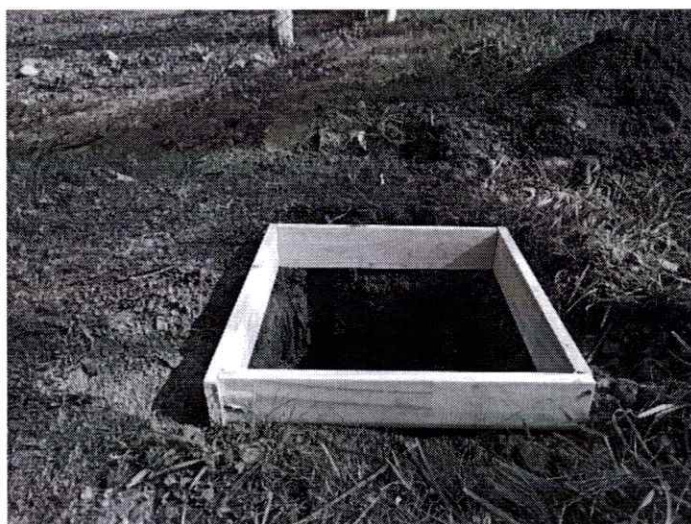
Fotografía 1. Ejemplo de Construcción de Monolitos RRP
