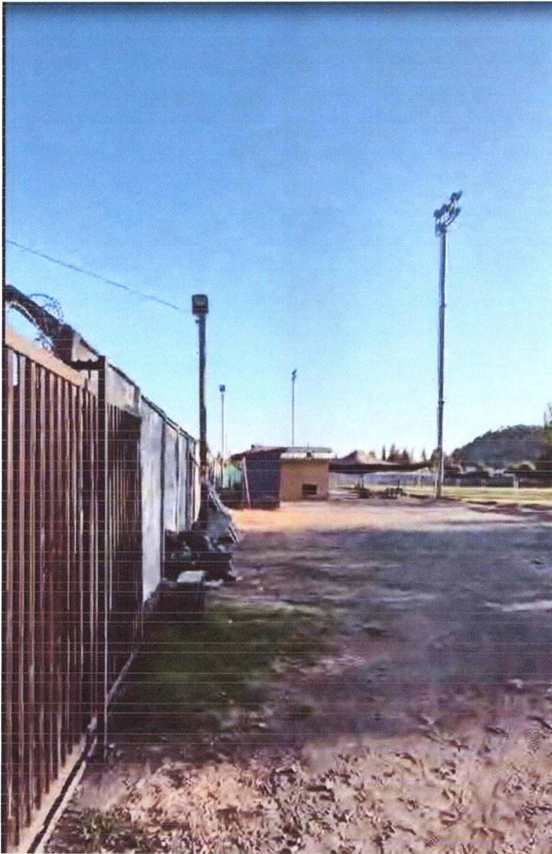
IMAGEN 4: ITEM 1.2 DEMOLICIONES Y RETIROS
