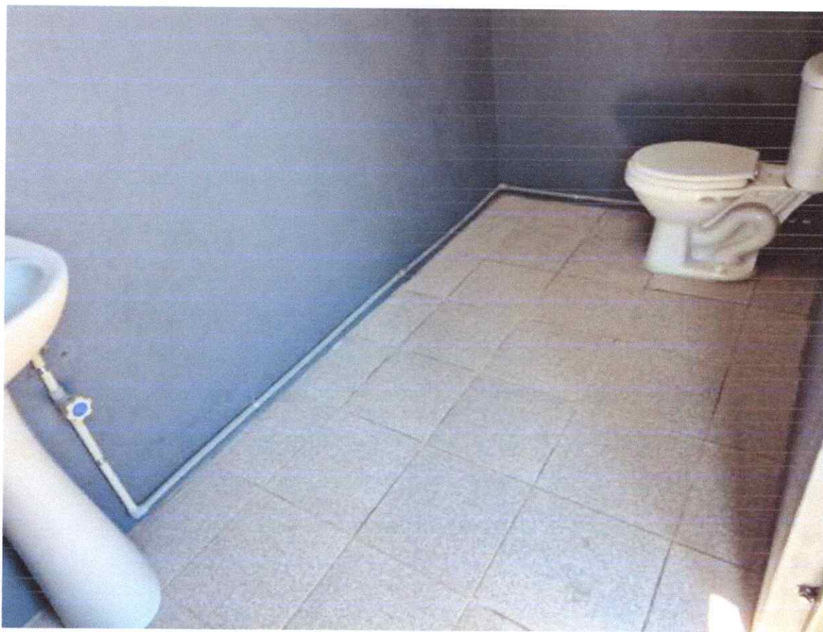
IMAGEN 22:ITEM 4.2 INSTALACION DE AGUA POTABLE.
