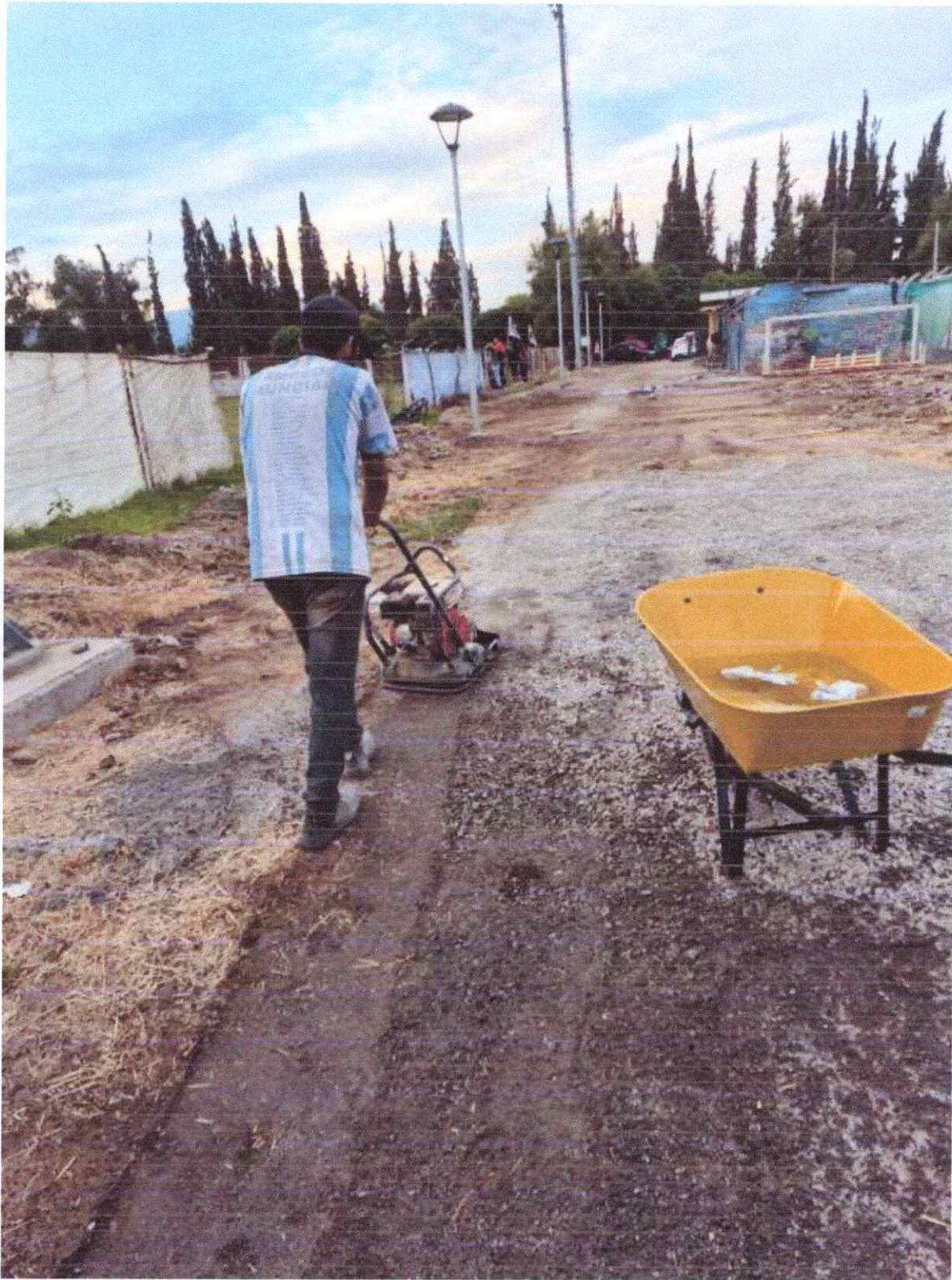
IMAGEN 31:ITEM 4.3 INSTALACION ELECTRICA.
