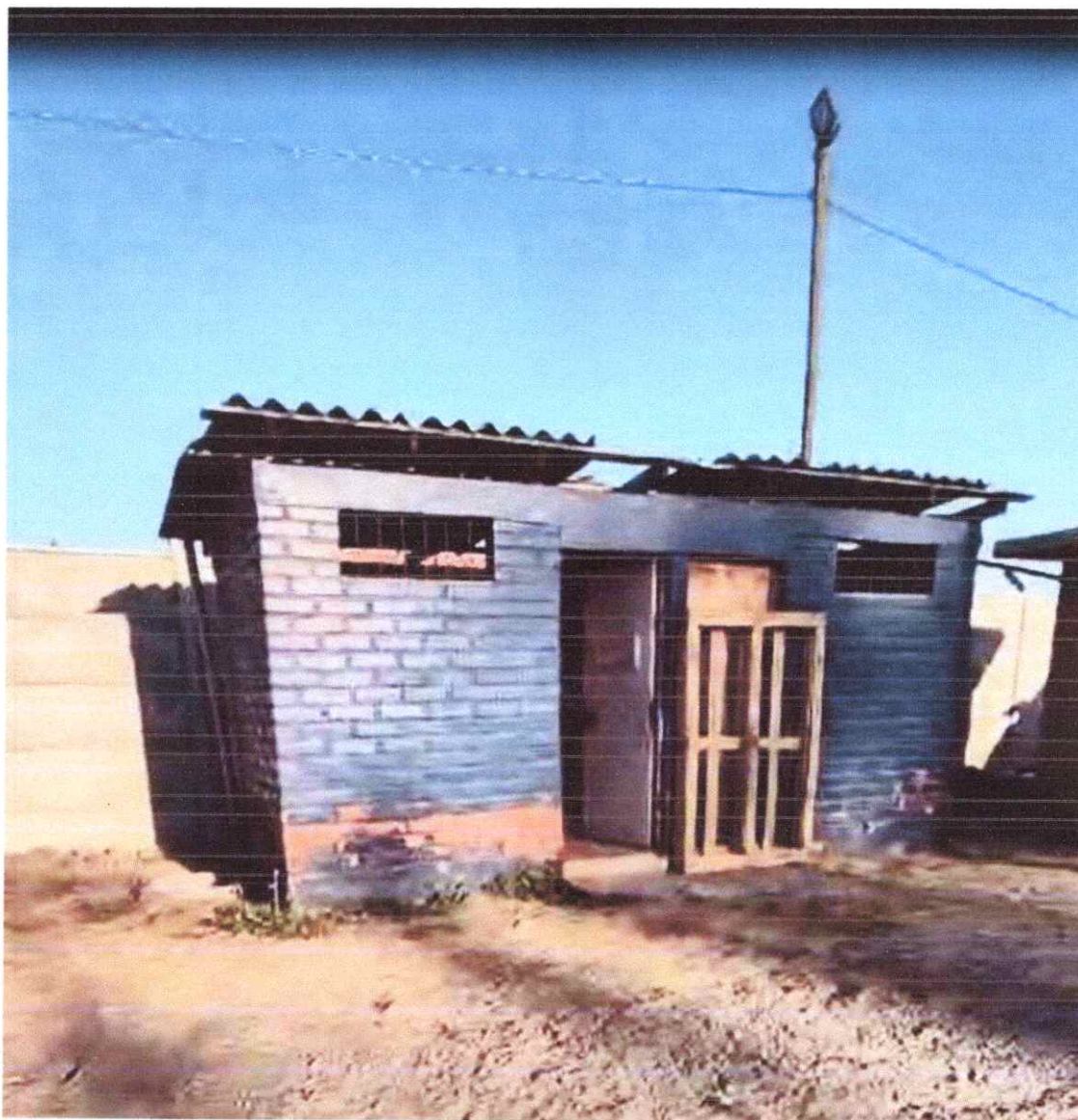
IMAGEN 2: ITEM 1.2 RETIRO Y DEMOLICIONES.
