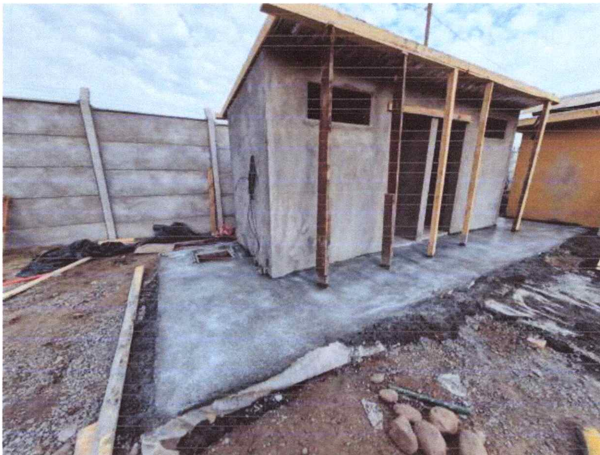
IMAGEN 8: ITEM 2.2 RADIER Y ZOCALO DE HORMIGON.
