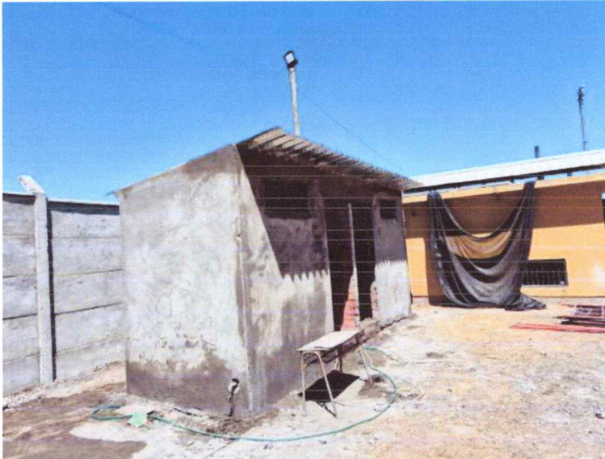
IMAGEN 7: ITEM 2.2 RADIER Y ZOCALO DE HORMIGON.
