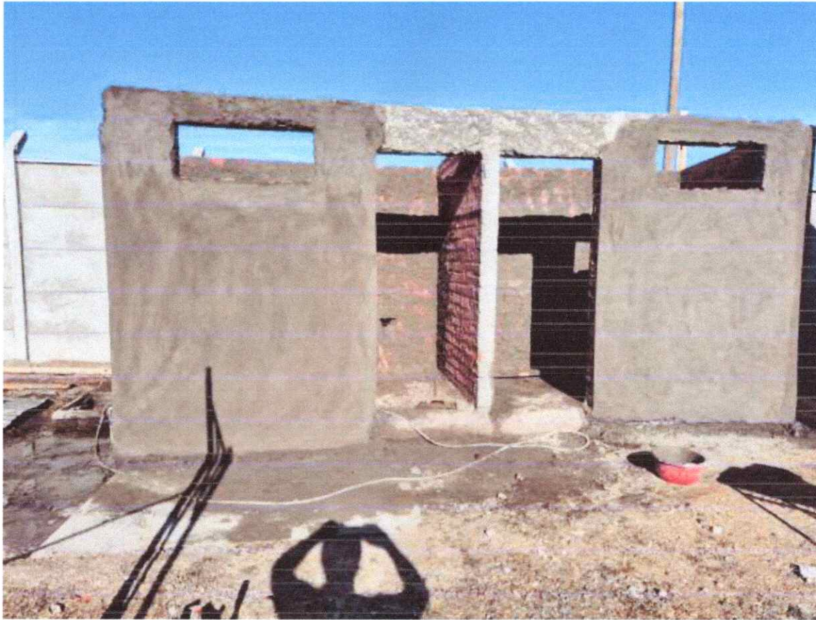
IMAGEN 11:ITEM 3.1 ESTUCO EXTERIOR E INTERIOR.
