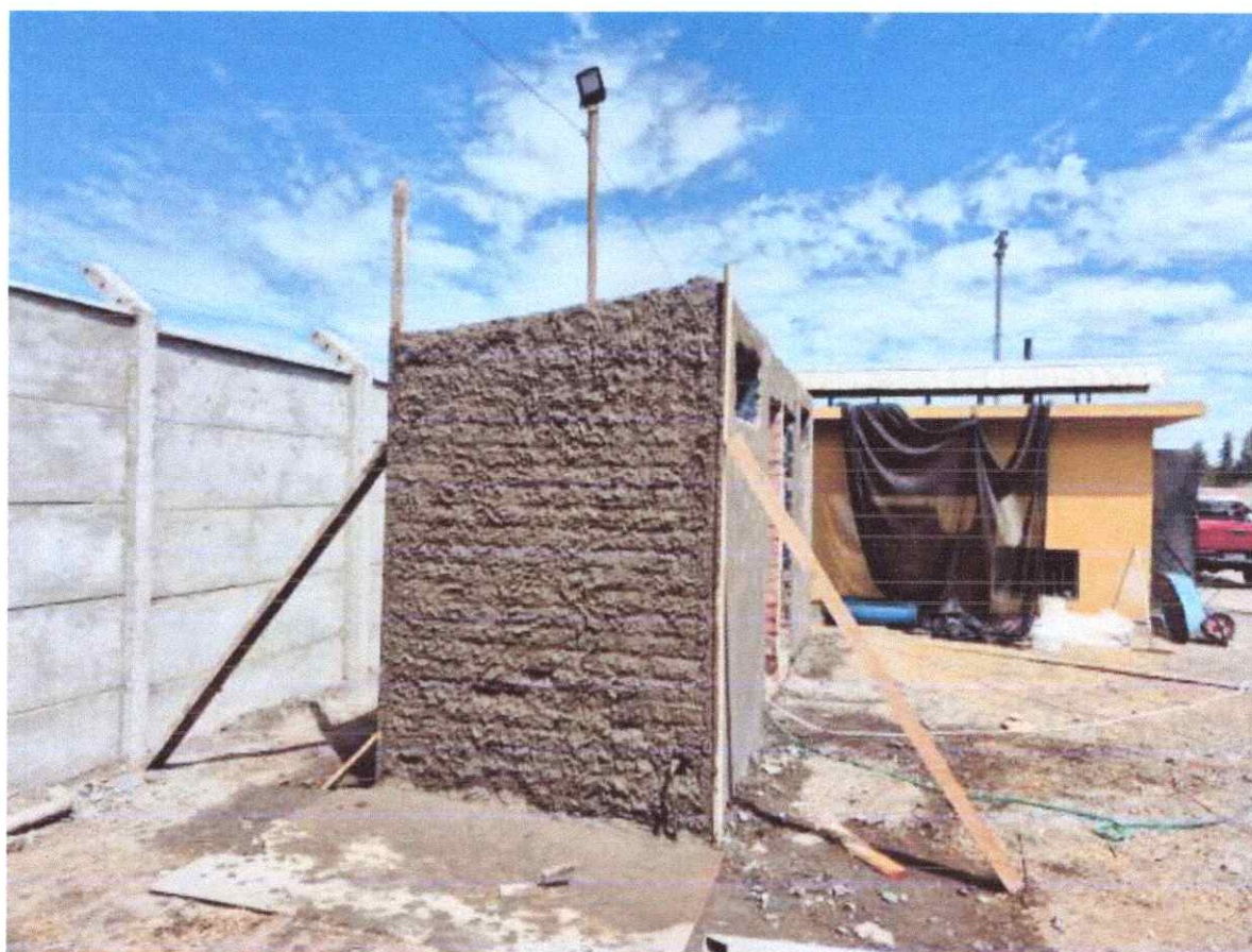
IMAGEN 10: ITEM 3.1 ESTUCO EXTERIOR E INTERIOR.
