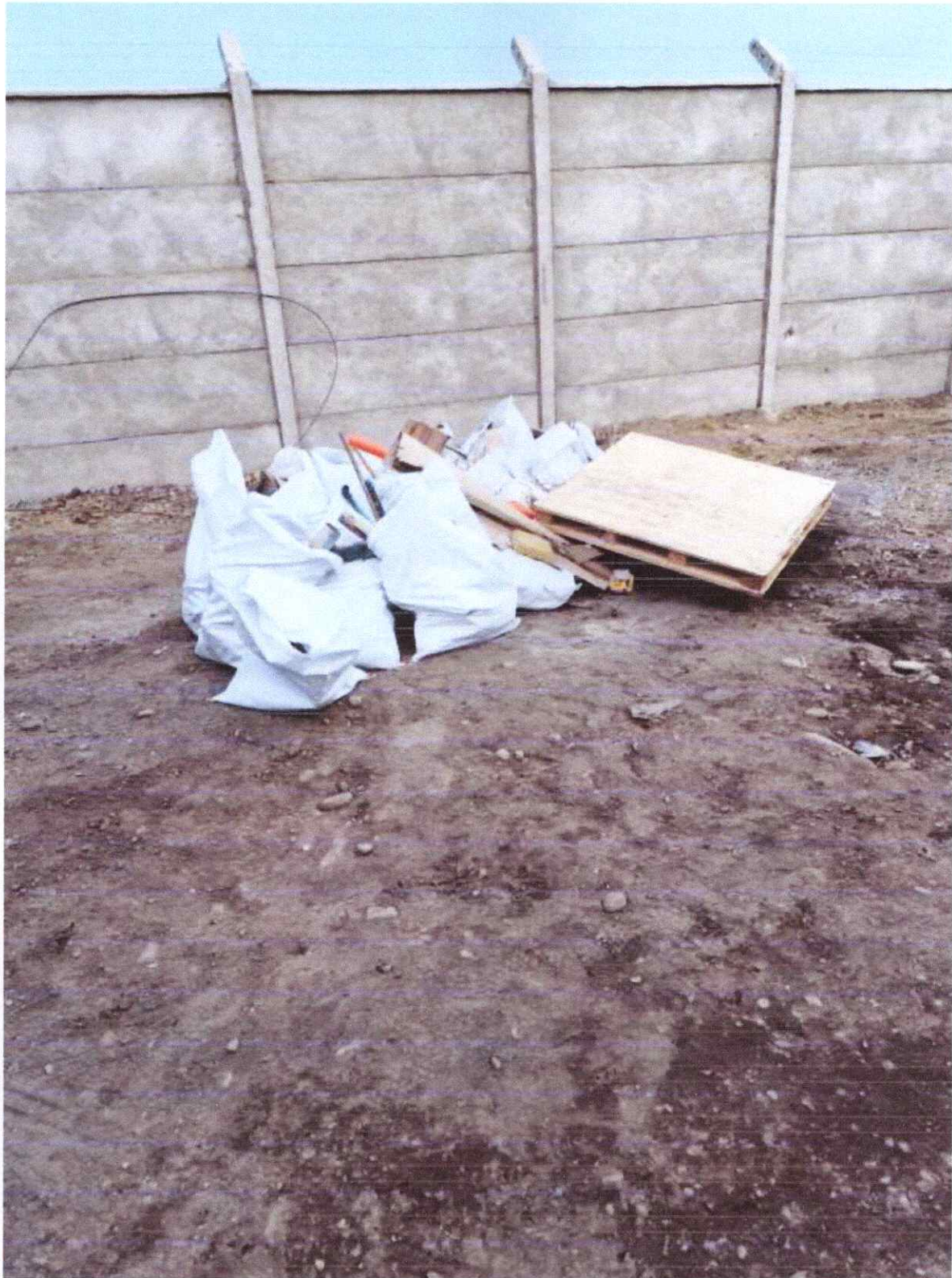
IMAGEN 34: ITEM 5 ASEO GENERAL, LIMPIEZA Y ENTREGA FINAL.
