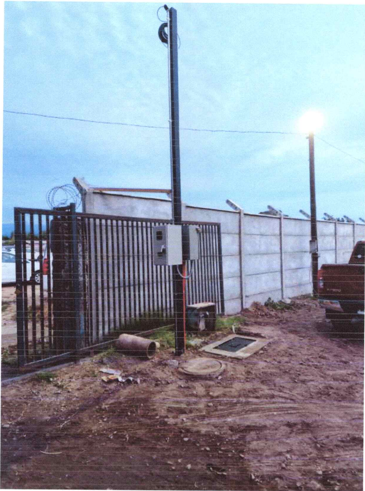
IMAGEN 21: ITEM 4.2 INSTALACION DE AGUA POTABLE.
