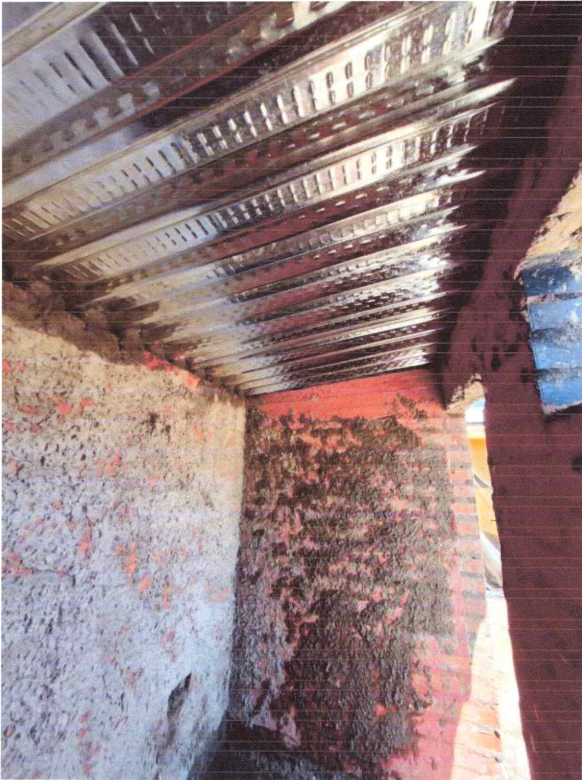
IMAGEN 6: ITEM 2.1 LOSA COLABORANTE CUBIERTA.
