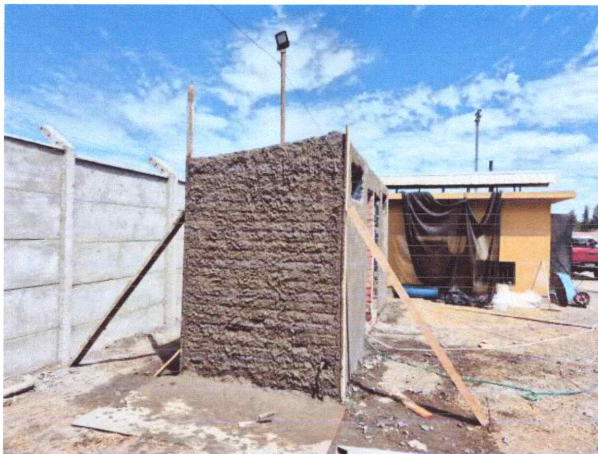
IMAGEN 10: ITEM 3.1 ESTUCO EXTERIOR E INTERIOR.
