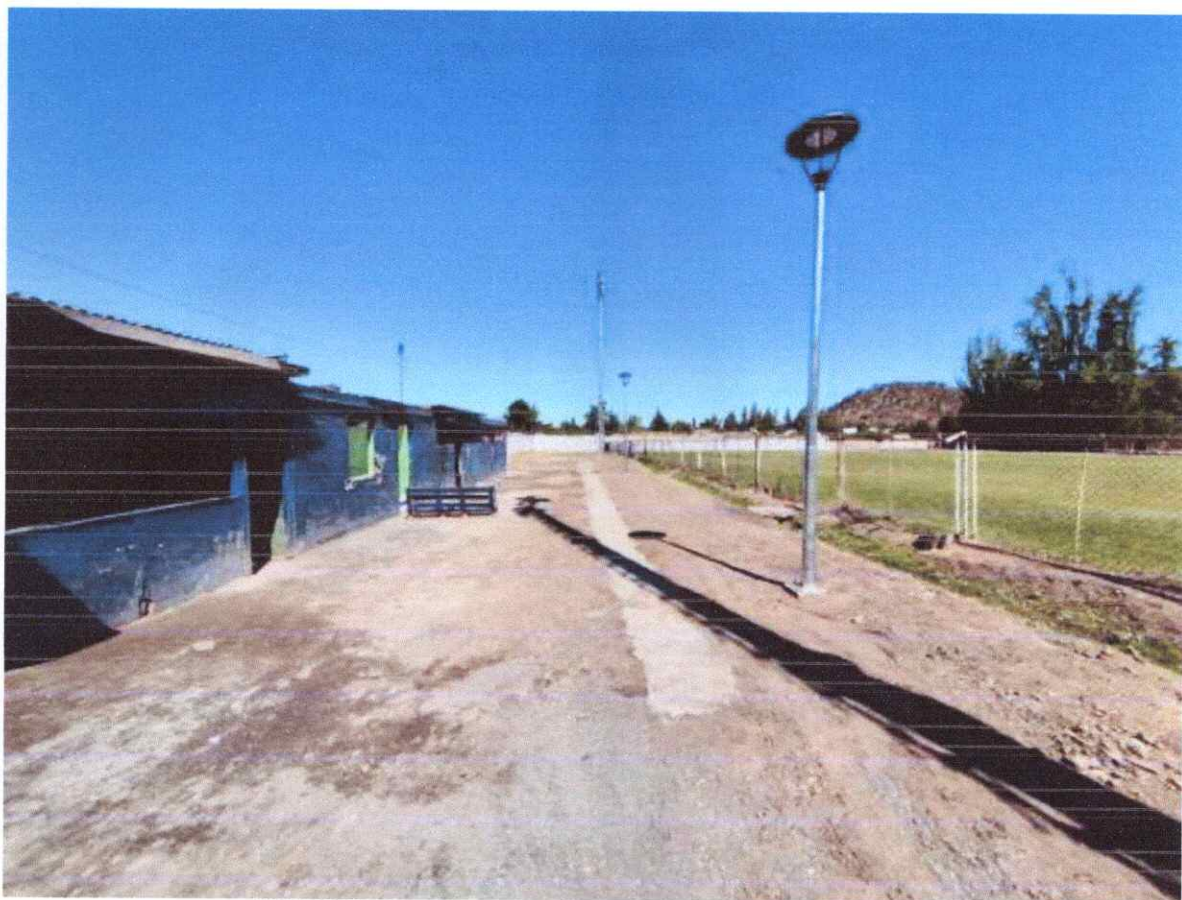
IMAGEN 33:ITEM 4.3 INSTALACION ELECTRICA.
