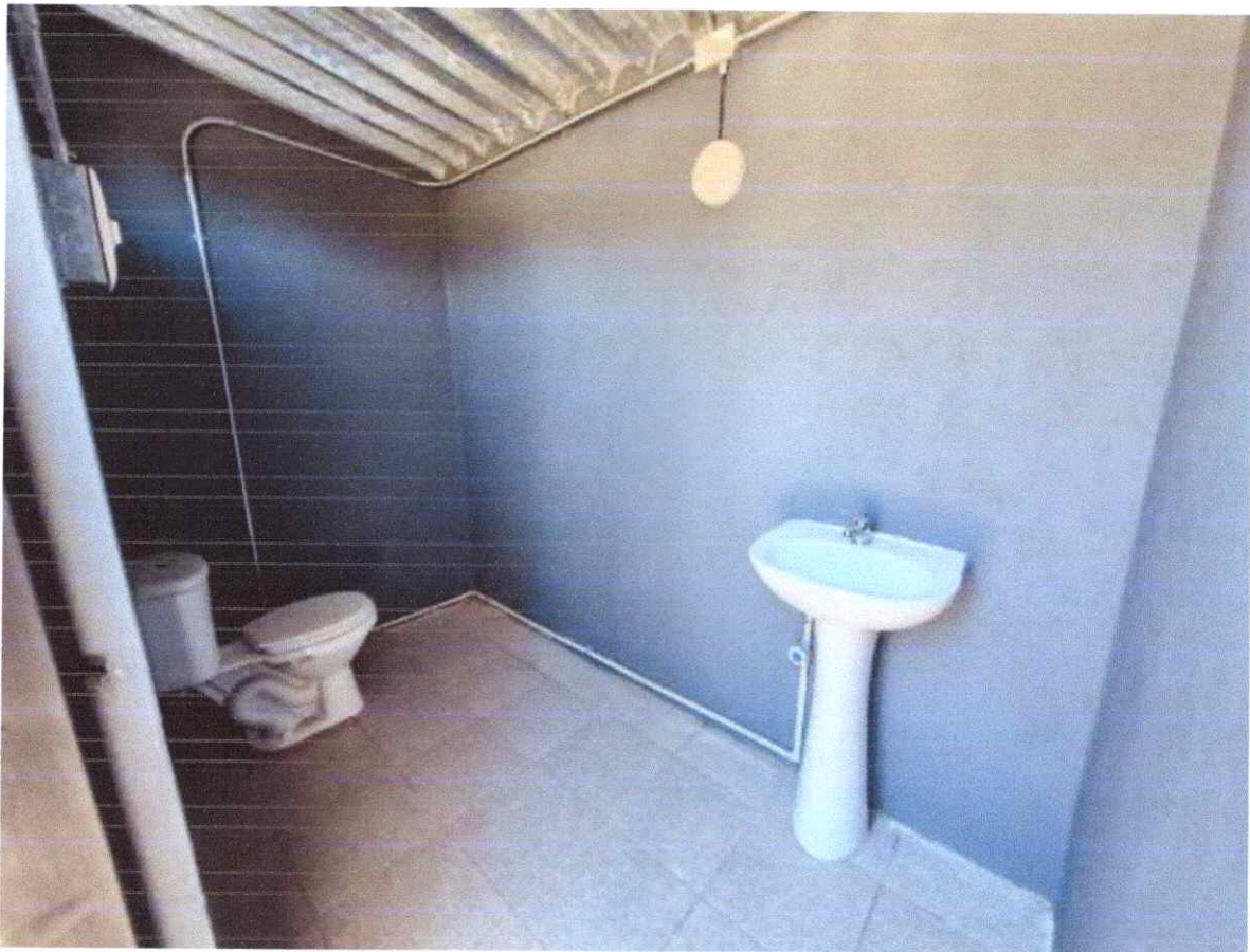
IMAGEN 32:ITEM 4.3 INSTALACION ELECTRICA.
