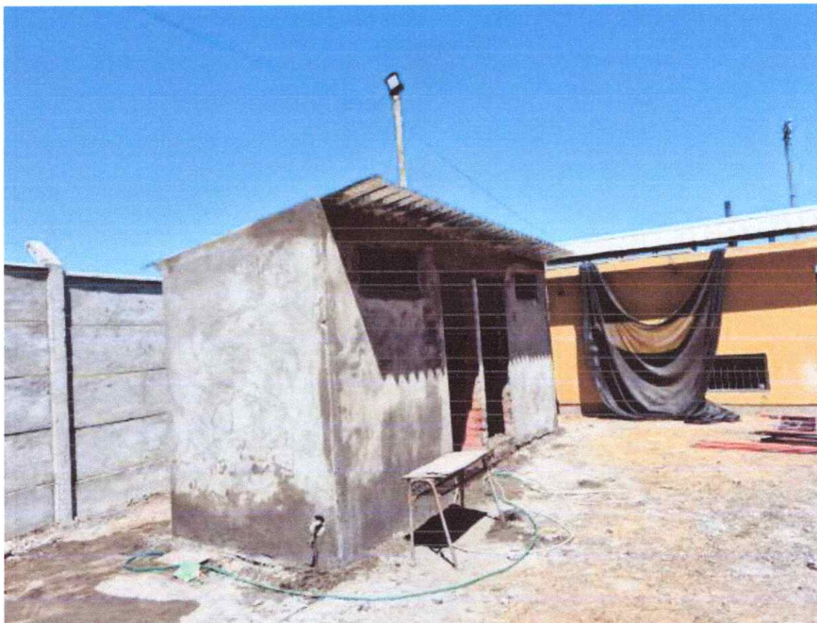
IMAGEN 7: ITEM 2.2 RADIER Y ZOCALO DE HORMIGON.
