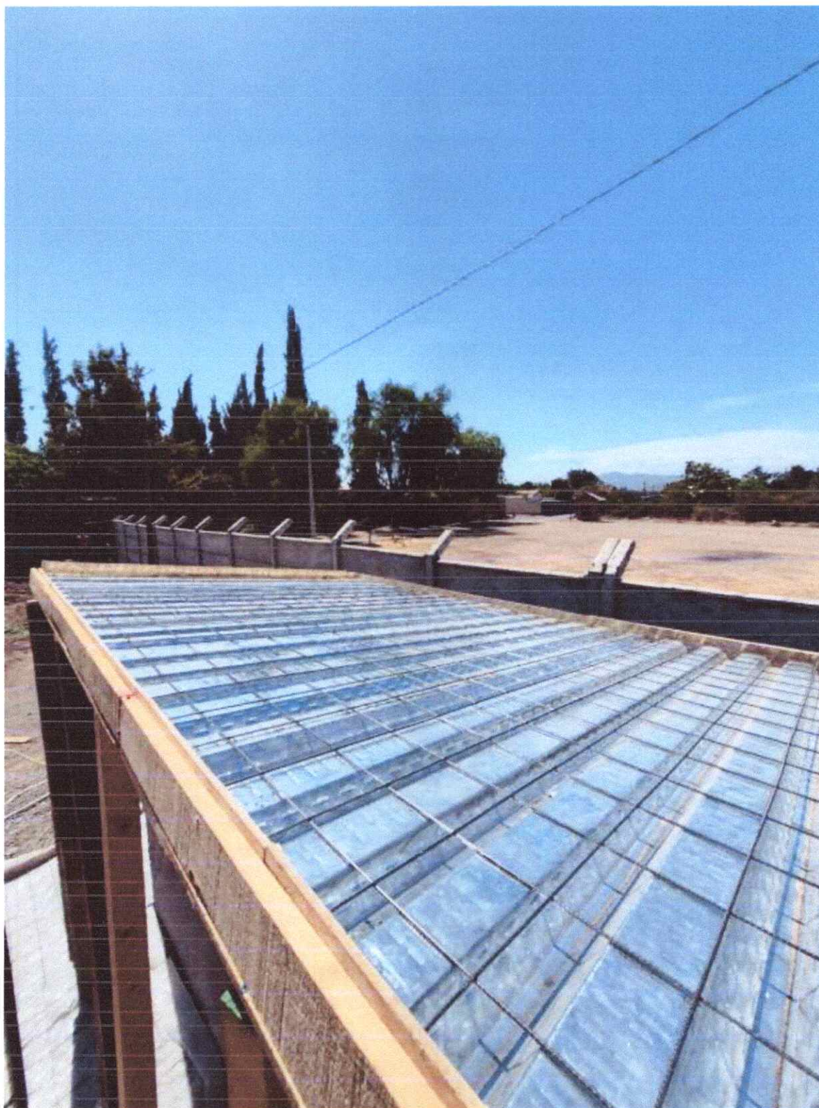
IMAGEN 5: ITEM 2.1 LOSA COLABORANTE CUBIERTA.
