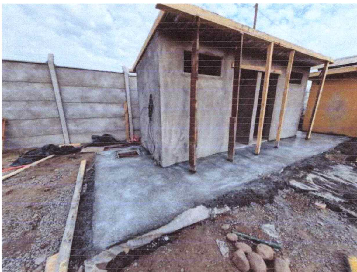
IMAGEN 8: ITEM 2.2 RADIER Y ZOCALO DE HORMIGON.
