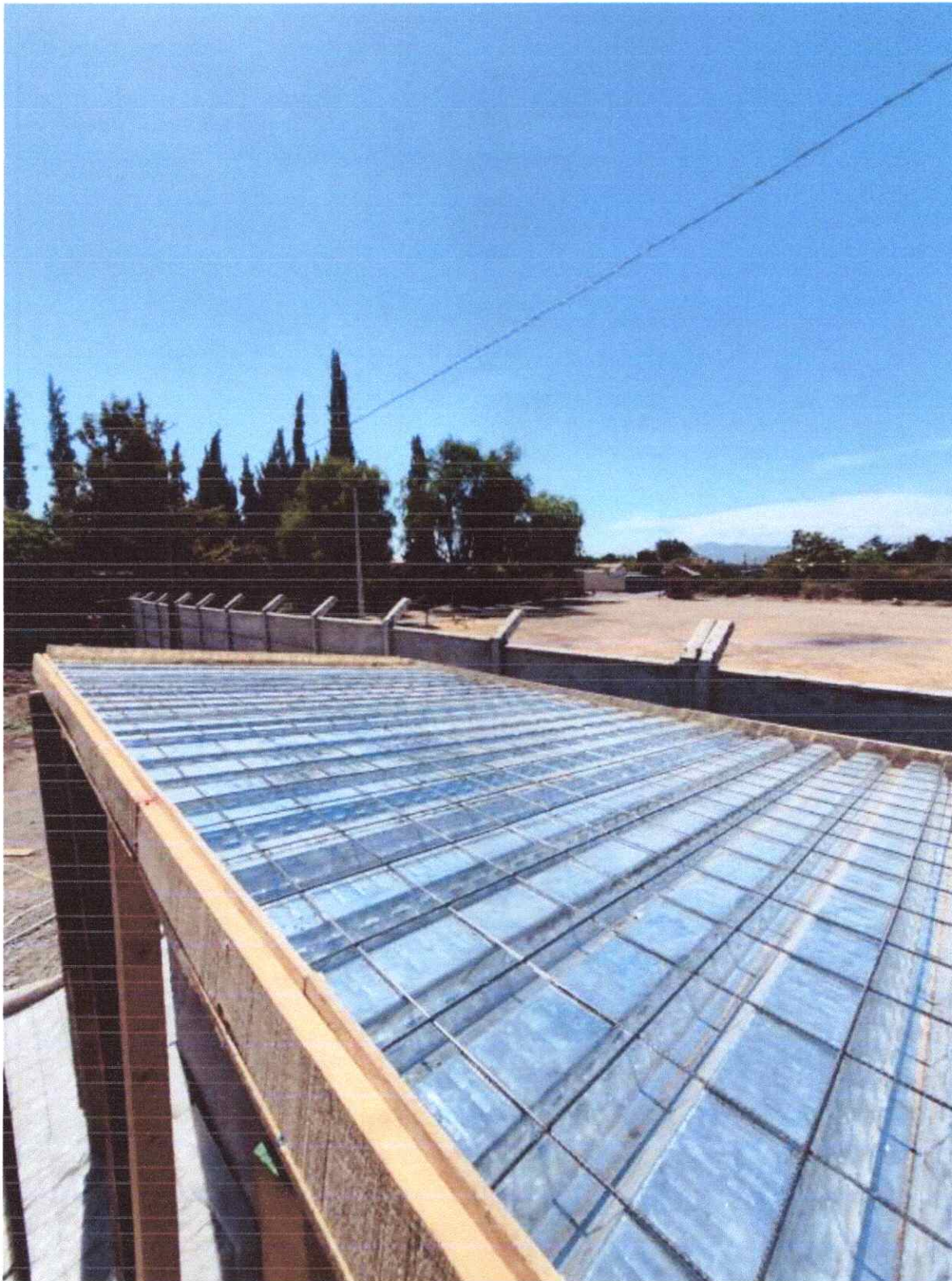
IMAGEN 5: ITEM 2.1 LOSA COLABORANTE CUBIERTA.
