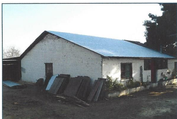
REPARACIONES BANCO MATERIALES
