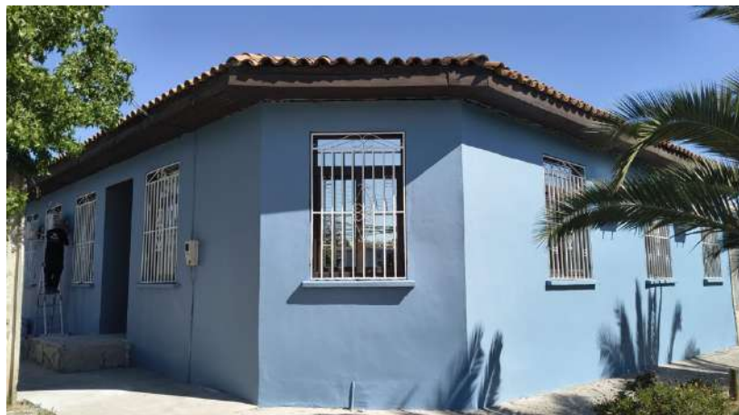
Imagen ejecución del proyecto.
