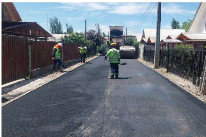
Imagen durante la ejecución del proyecto.
