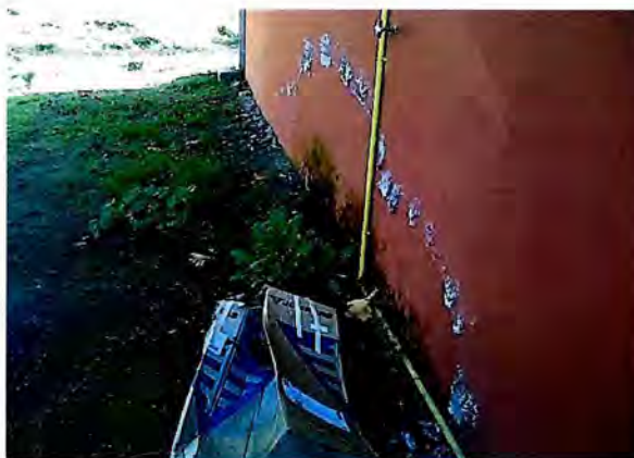
Fotografía N° 21: Detalle del estado de superficies exteriores de muros.
