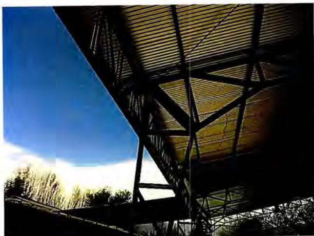
Fotografía N° 36: Detalle de instalación eléctrica en recinto.
