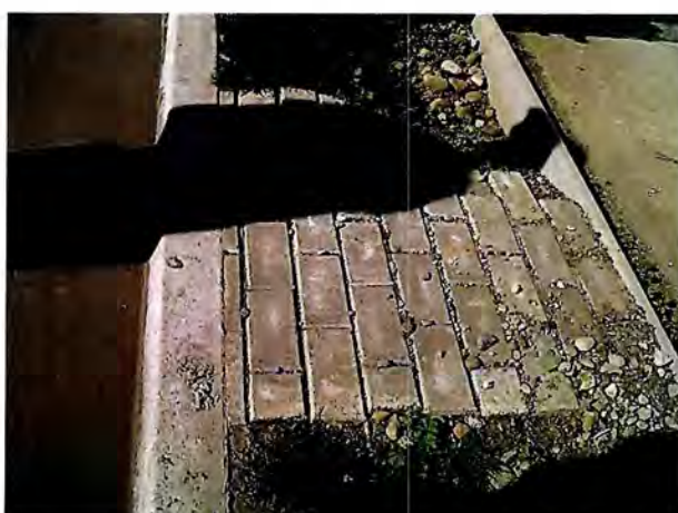
Fotografía N° 39: Detalle de pavimento de adoquines ejecutado.
