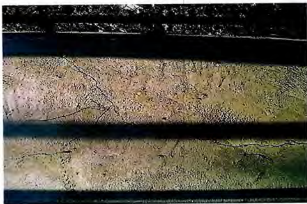
Fotografía N° 20: Detalle de la superficie del pavimento.
