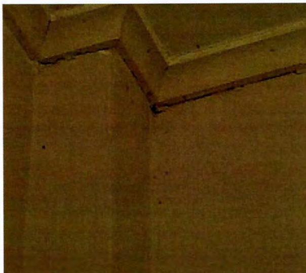
Fotografía N° 23: Detalle de encuentro de muro y cielo.
