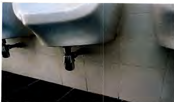
Fotografía N° 1: Vista del artefacto que presenta deficiente sellado en su descarga.
