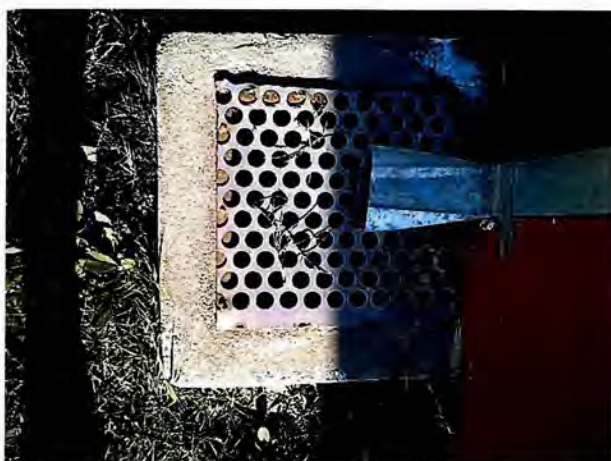
Fotografía N° 19: Detalle de baja de aguas lluvias.
