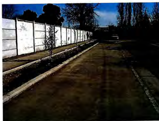
Fotografía N° 43: Vista del estado de las áreas verdes.
