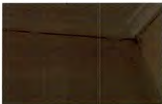
Fotografía N°22: Vista superior de muro y encuentro de cielo.
