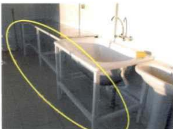
Fotografía N° 07: Vista de la solución de lavafondos instalada en cocina general del establecimiento.
