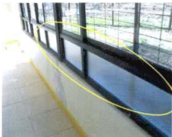
Fotografía N° 01: Detalle de instalación de vidrios de policarbonato semitransparentes en Sala de Actividades
