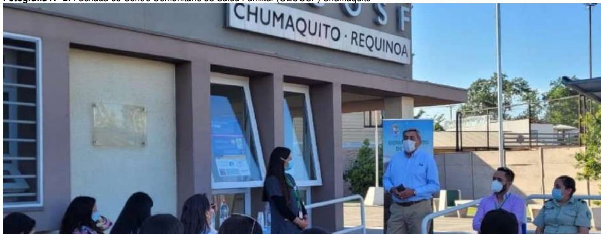
Fotografía N° 2: Fachada de Centro Comunitario de Salud Familiar (CECOSF) Chumaquito
