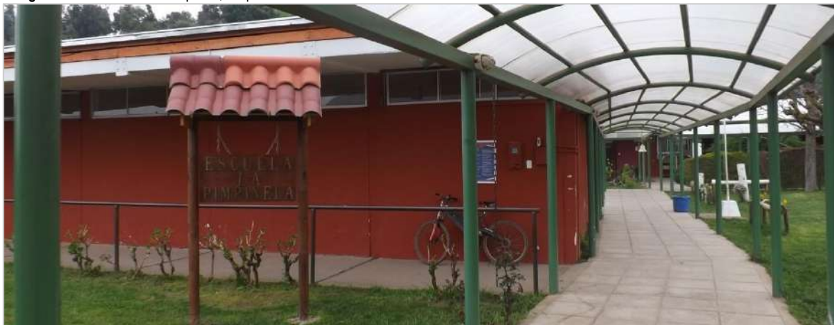
Fotografía N° 7: Escuela La Pimpinela, Requinoa
