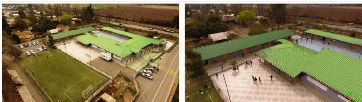
Fotografía N° 9: Escuela David del Curto, Requinoa
